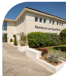
Résidence EHPAD Les Aigueillères Montferrier-sur-Lez (34)
