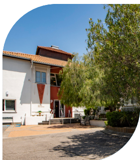
Résidence EHPAD L'Ensoleillade Lattes (34)
