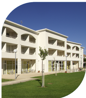
Résidence EHPAD Les Lavandes Florensac (34)
